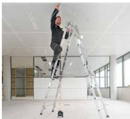
¡Puntos de plomada para una perfecta alineación entre techo y piso!
