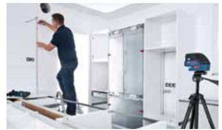
Instale spots y luminarias
