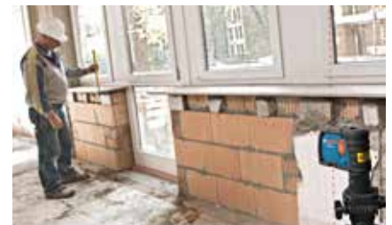
Transferencia de puntos para trabajos de nivelación
